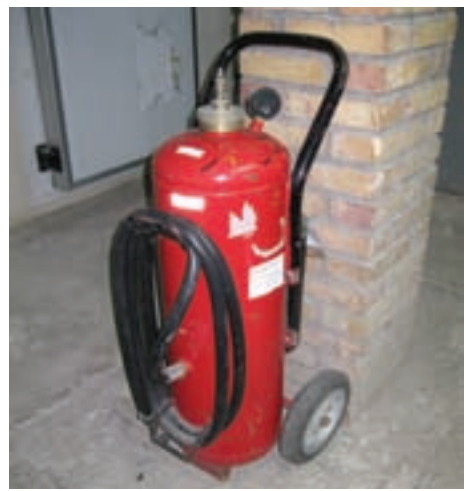
شکل ۱۵-۱ تجهیزات آتش‌نشانی
