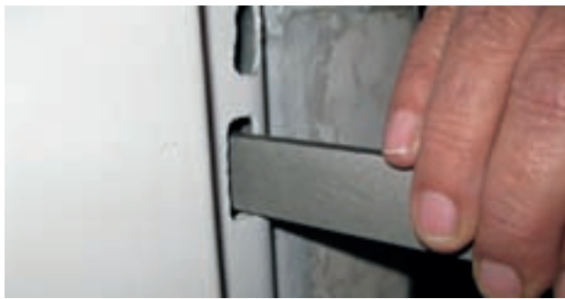
شکل ۱-۴ سوهان کاری زبانه در
